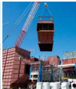
Installation d'un système de traitement des fumées
