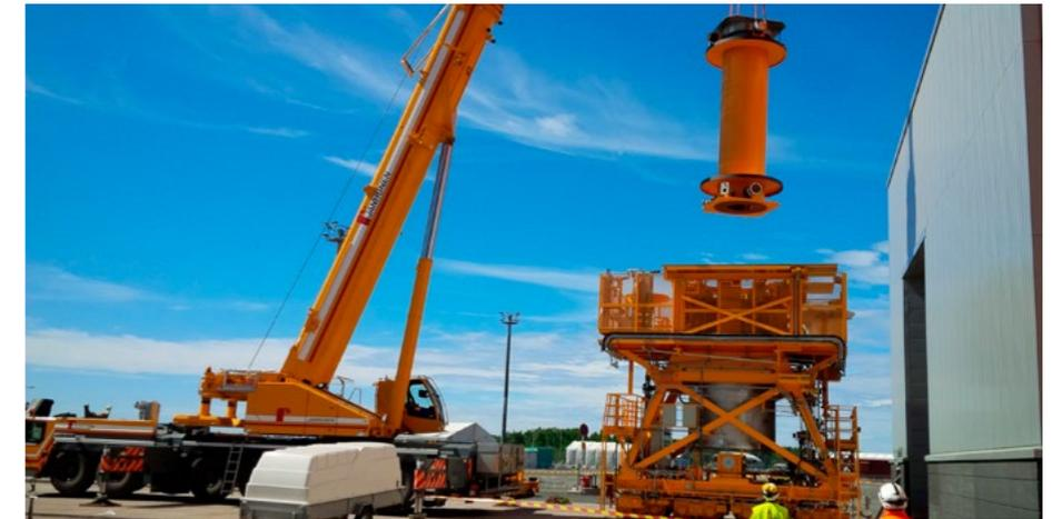
Essai en charge du chariot de manutention du combustible usé sur l'EPR OL3
