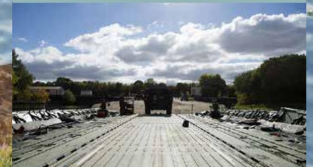
Afin de répondre aux enjeux du terrain le PFM, solution de franchissement tactique et d'appui logistique, peut être déployé selon deux configurations, **pont ou portière**.
