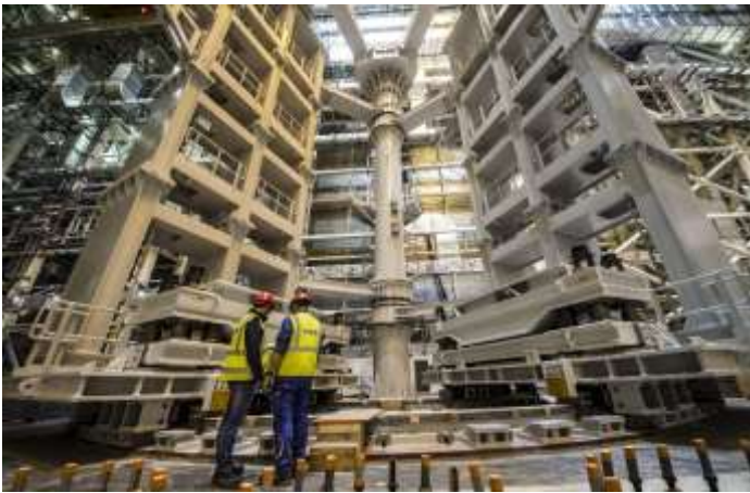
Figure 2: Montage du SSAT n°2 © ITER Org
